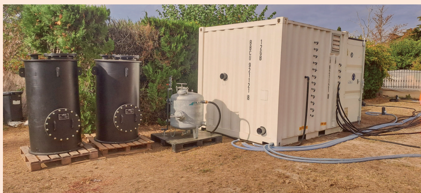
Proyecto desarrollado por Séché Group en Cougneaux, Toulouse, Francia para la remediación mediante Sparging/Venting de un sitio vecino a estación de servicio con filtraciones subterráneas de combustible. Superior: Skid de tratamiento. Inferior: Intervención del sitio para colocación de pozos de inyección/extracción.
