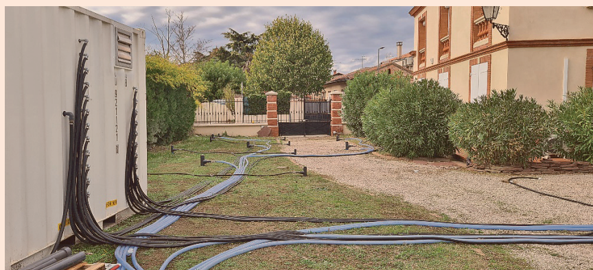
Proyecto desarrollado por Séché Group en Cougneaux, Toulouse, Francia para la remediación mediante Sparging/Venting de un sitio vecino a estación de servicio con filtraciones subterráneas de combustible. Superior: Skid de tratamiento. Inferior: Intervención del sitio para colocación de pozos de inyección/extracción.
